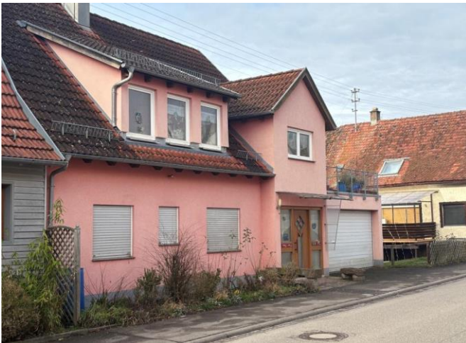
(6) Ansicht Nord – Ost von der Hauptstraße
