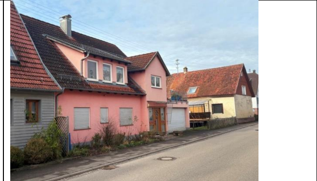
Ansicht von der Straße Bewertungsobjekt an das Nachbargebäude angebaut
