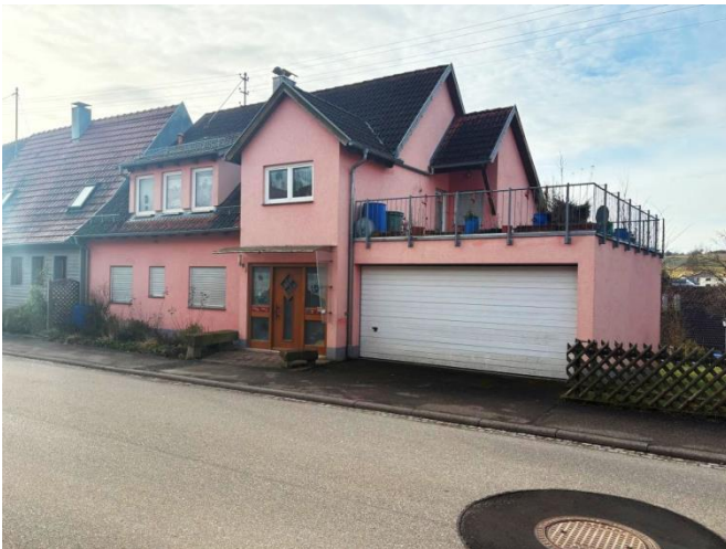
(8) Ansicht Nord – Ost von der Hauptstraße
